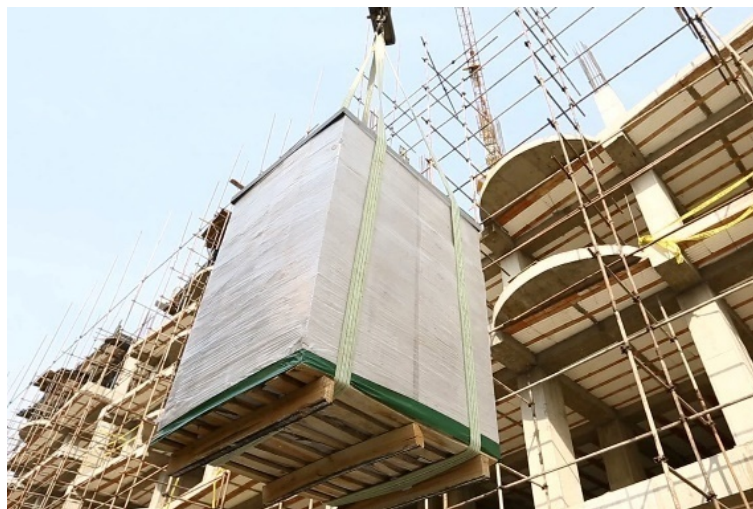
شکل ۱-۱۱- انتقال پالت‌های بلوک‌های AAC در کارگاه
